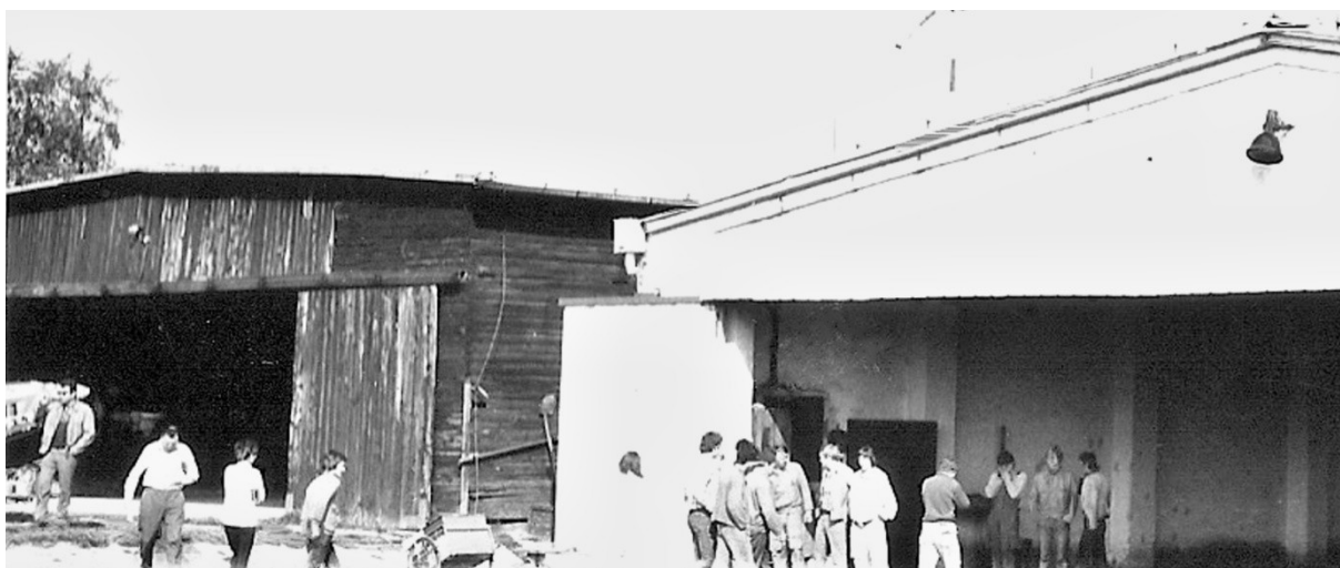
Takto vypadal „dřevěný“ hangár před započatím stavebních prací; Nový Dvůr, březen 1974
